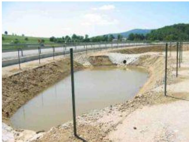
Abbildung II-3: Regenrückhaltebecken einer Straße in Bayern [1]
