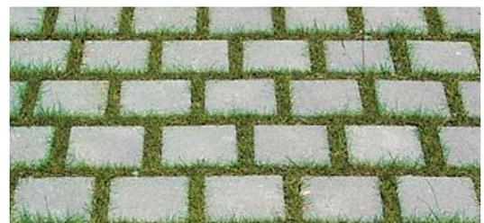
Abbildung II-20: Porenpflaster mit Gras als Befüllung
