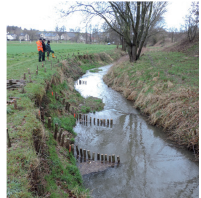
Böschungssicherung mit Steckhölzern und Rechenbuhnen im Mutzschener Wasser, Sachsen
