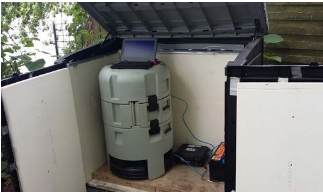
Messstelle mit automatischem Probennehmern in der Berliner Unterhavel zur ereignisbezogenen Probennahme nach Starkregenereignissen, Foto: Kompetenzzentrum Wasser Berlin gGmbH
