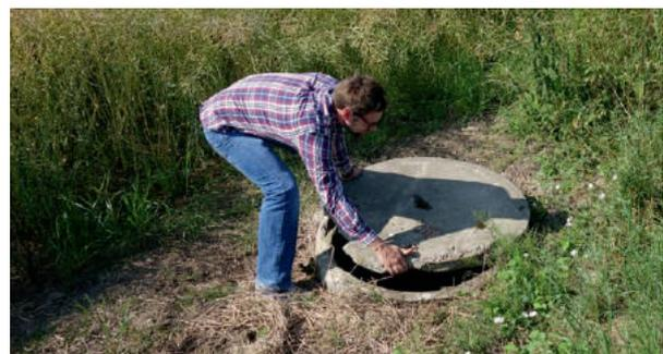
Gelangen Pestizide aus der Landwirtschaft ins Grundwasser? Um das zu klären, wird aus dem Drainageschacht eine Wasserprobe gezogen.
