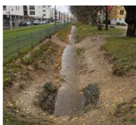
Links: LC-MS zur Analytik der Pestizide und TP. Mitte: Photolyse der Pestizide im Labor. Rechts: Mulden-Rigolen-System in der Stadt Freiburg.
